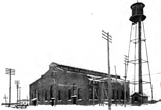
FIG. 1.—SUB-STATION AT MAISONNEUVE.
